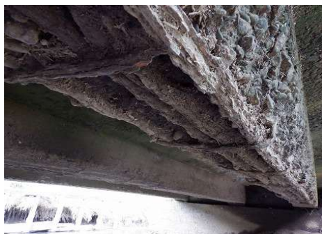
No40_愛宕台2号 (主桁) 剥離・鉄筋露出
