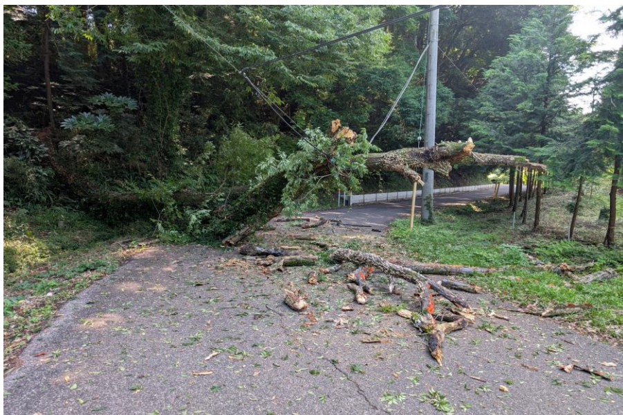
倒木し、通信線が垂れ下がる(森地先)
