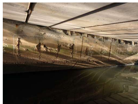
No.26 木戸浜3号橋(健全性Ⅲ) (下部工) 剥離・鉄筋露出 海岸線距離 0.9 km
