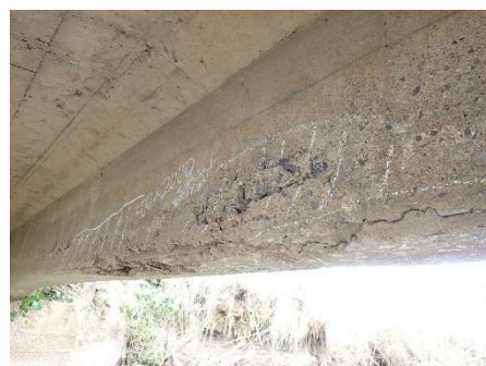
No.411 町田橋(健全性Ⅲ) (主桁) 剥離・鉄筋露出 海岸線距離 10.3 km
