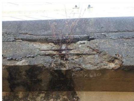
No.1 板附橋(健全性Ⅲ) (主桁) 剥離・鉄筋露出 海岸線距離 9.8 km
