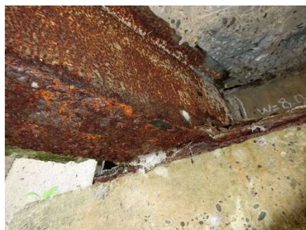
No.297 田越11号橋(健全性Ⅲ) (主桁) 腐食 海岸線距離 7.6 km
