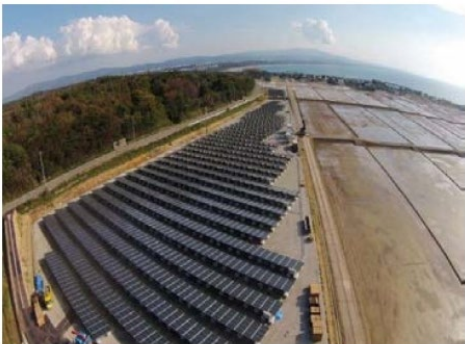
発電施設の外観
