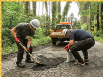
▲道路補修(穴埋め)作業
