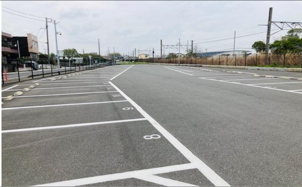
松尾駅前駐車場
