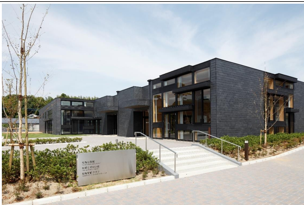
松尾交流センター 洗心館 (全景)
