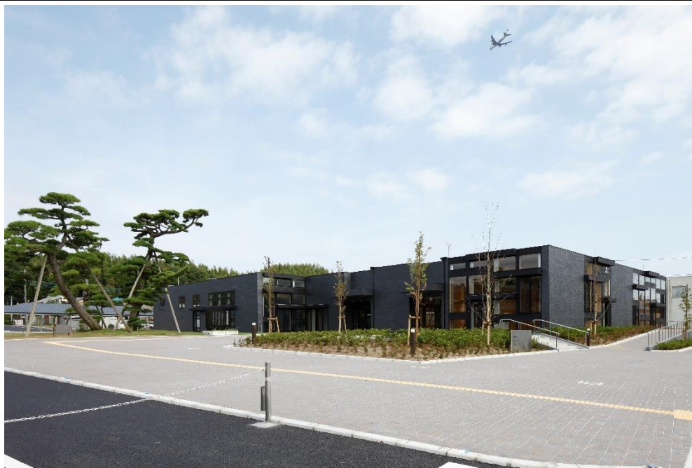
松尾交流センター 洗心館 (全景)
