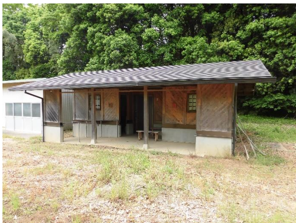
▼屋外トイレ外観
