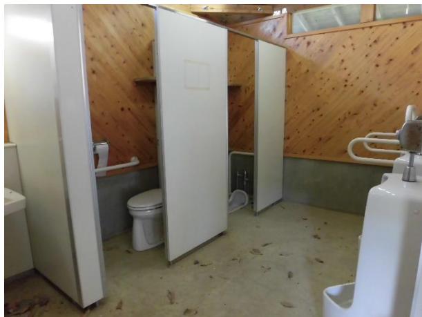
▼屋外トイレ内観
