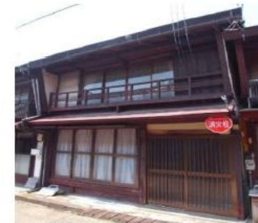
<改修事例 ～整備前の全景>
