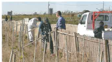
補強している様子
