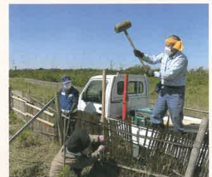
支えの杭を打ち込んで
