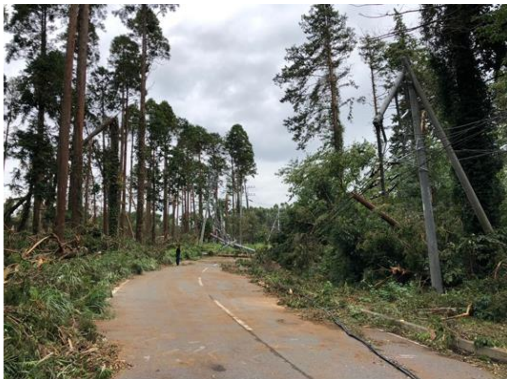
写真 7 台風被害状況②
