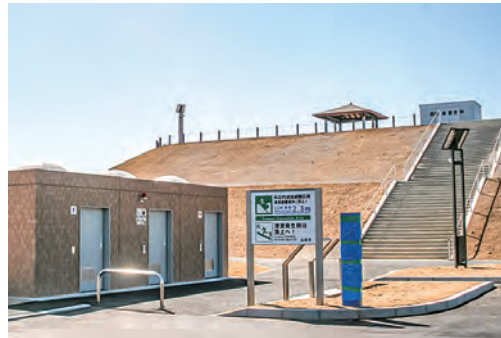
井之内津波避難施設
