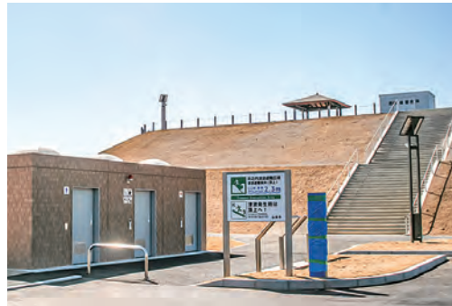
井之内津波避難施設
