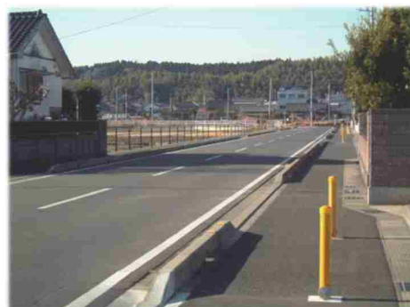
【改良された生活道路】
