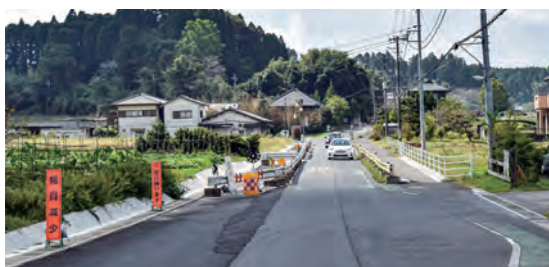
雨坪地先の県道
