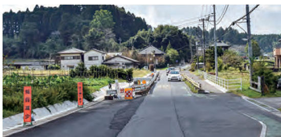
雨坪地先の県道
