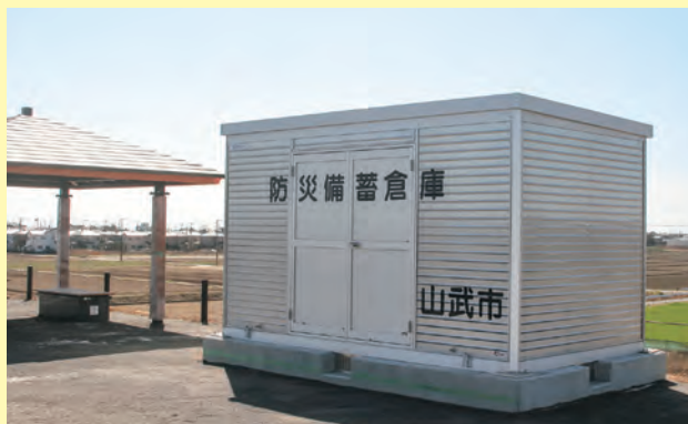
▲施設内に設置された防災備蓄倉庫
