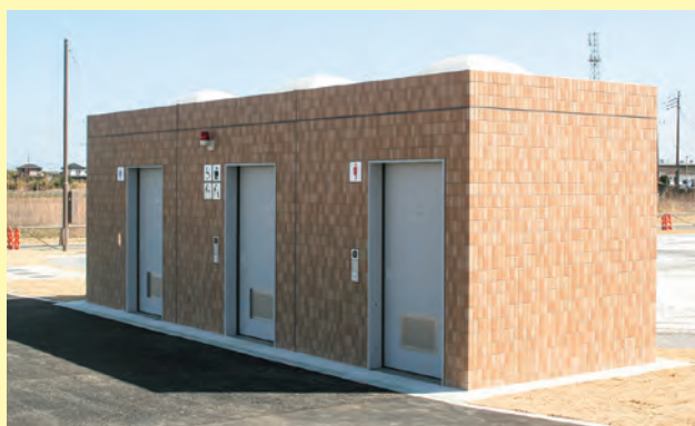
▲要支援者にも対応した常設トイレ
