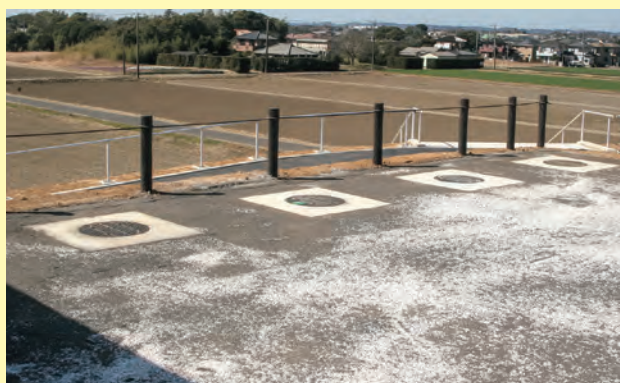
▲災害時にはトイレとして利用できるマンホール
