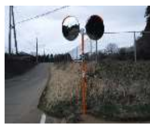
新設されたカーブミラー
