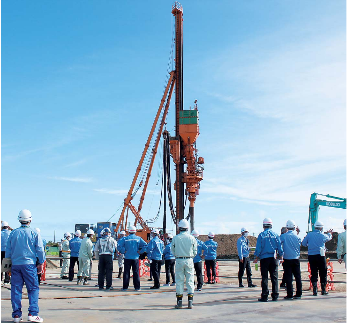
9月2日に、来年3月の完成を目指し井之内地区で整備が進められている、津波避難施設（築山）の工事現場を視察しました。
