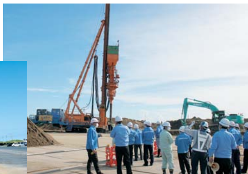
順調に工事が進められている築山
