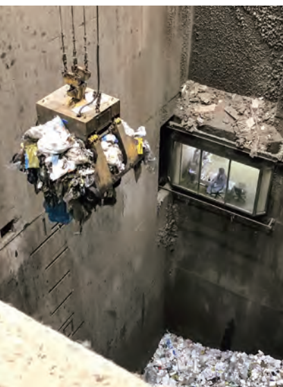
焼却炉のごみをかき混ぜる作業
