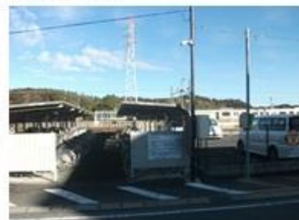
現況写真③
