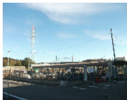
現況写真①
