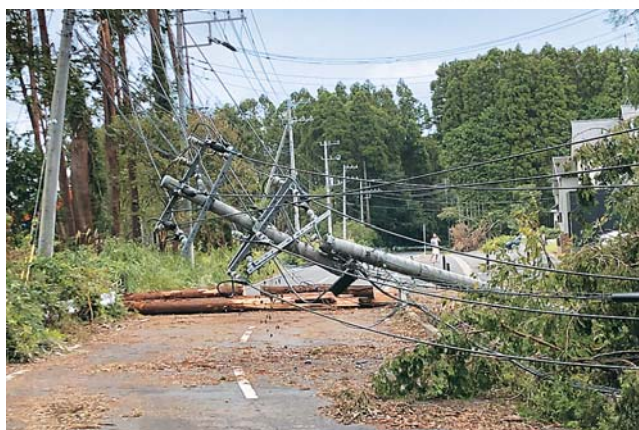
台風による倒木・電柱倒壊
