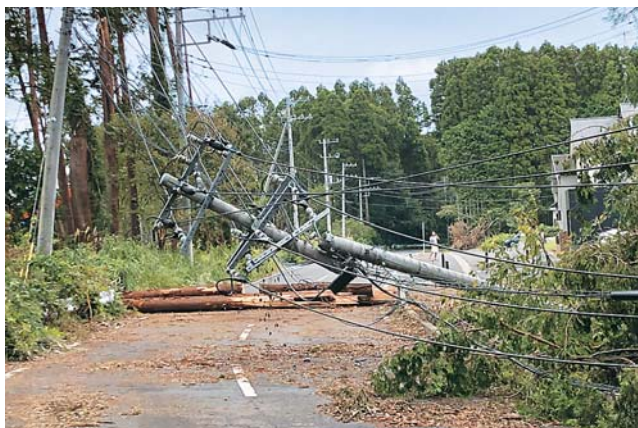
台風による倒木・電柱倒壊
