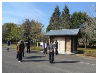
さんぶの森公園内にあるサンブスギを使用した防災備蓄倉庫です。
