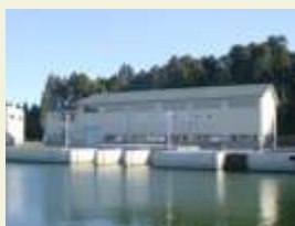
両総用水第3揚水機場
