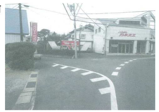
路側帯へ車両が進入しやすく危険な状態
