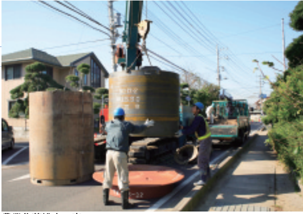
農業集落排水工事
