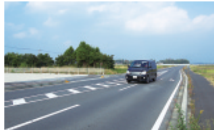
整備された市道
