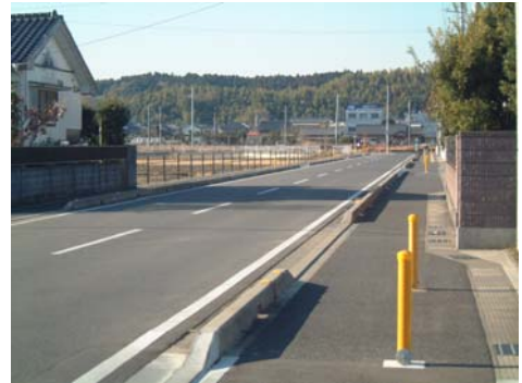
【改良された生活道路】
