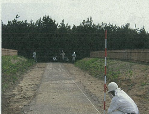
盛土工法による森林造成
