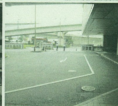
エントランス側車両出入口
