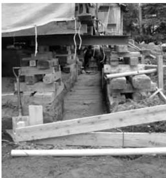
この基礎工事のために、母屋全体を地面から1m程ジャッキアップして(右写真参照)その隙間に身体を潜めて手作業で布堀を掘つたのです。
