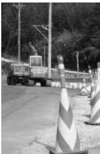
木原地先の松崎、滝ノ谷線土留工事
