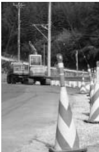
木原地先の松崎、滝ノ谷線土留工事
