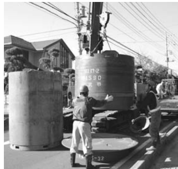
農業集落排水工事
