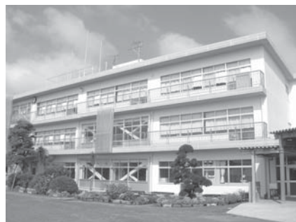
鉄骨枠と外壁の塗り替えてきれいになった蓮沼小学校
