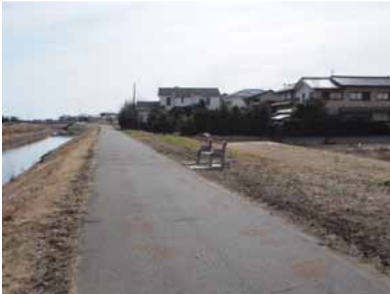
写真 5-5 成東大橋付近の土手
