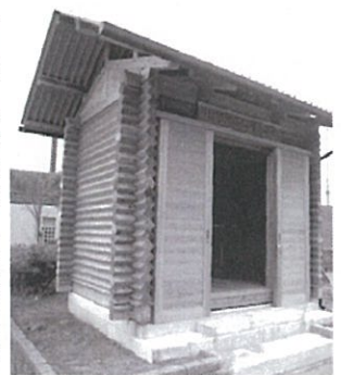
●成東総合運動公園に設置されたサンプルの木造防災備蓄倉庫
