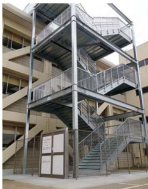
完成した蓮沼中学校避難用外階段
