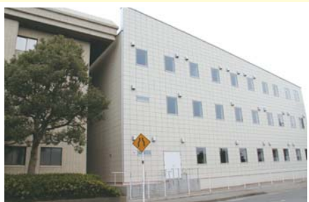
のぎくプラザから見る庁舎外観
