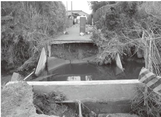
津波によって橋が破壊された 写真提供 渡辺さん
