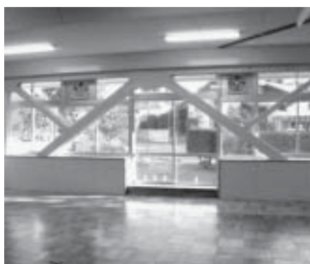
耐震工事が施された教室の様子
