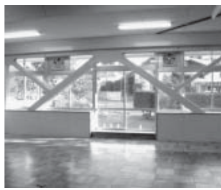
耐震工事が施された教室の様子
