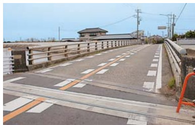
歩道整備が待たれる緑海橋
