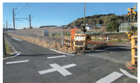
成東中学校手前の踏切
