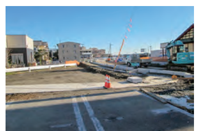
成東304号線工事(平成29年12月25日撮影)
