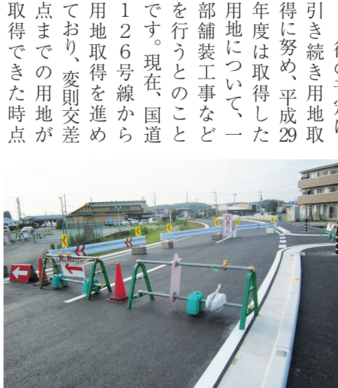
整備が進む成東304号線 (市役所～すぎのや本陣脇)
